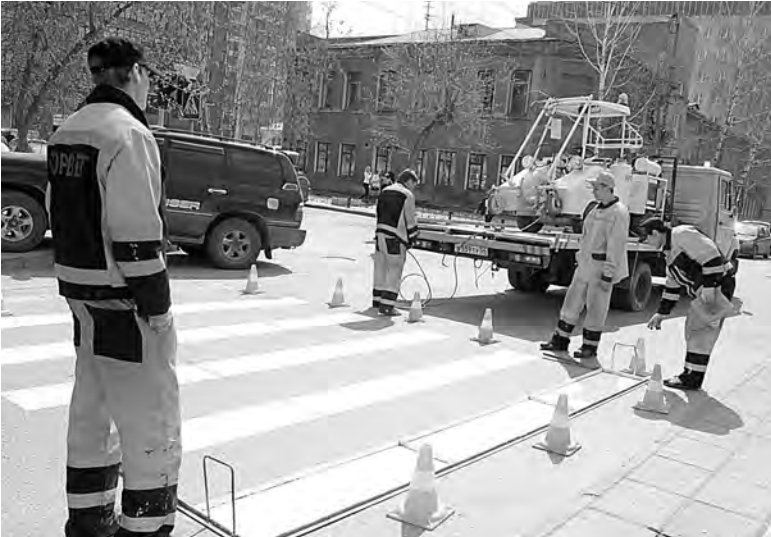
Опыт показал, что наносить пластиковую разметку перед началом зимы неэффективно.
