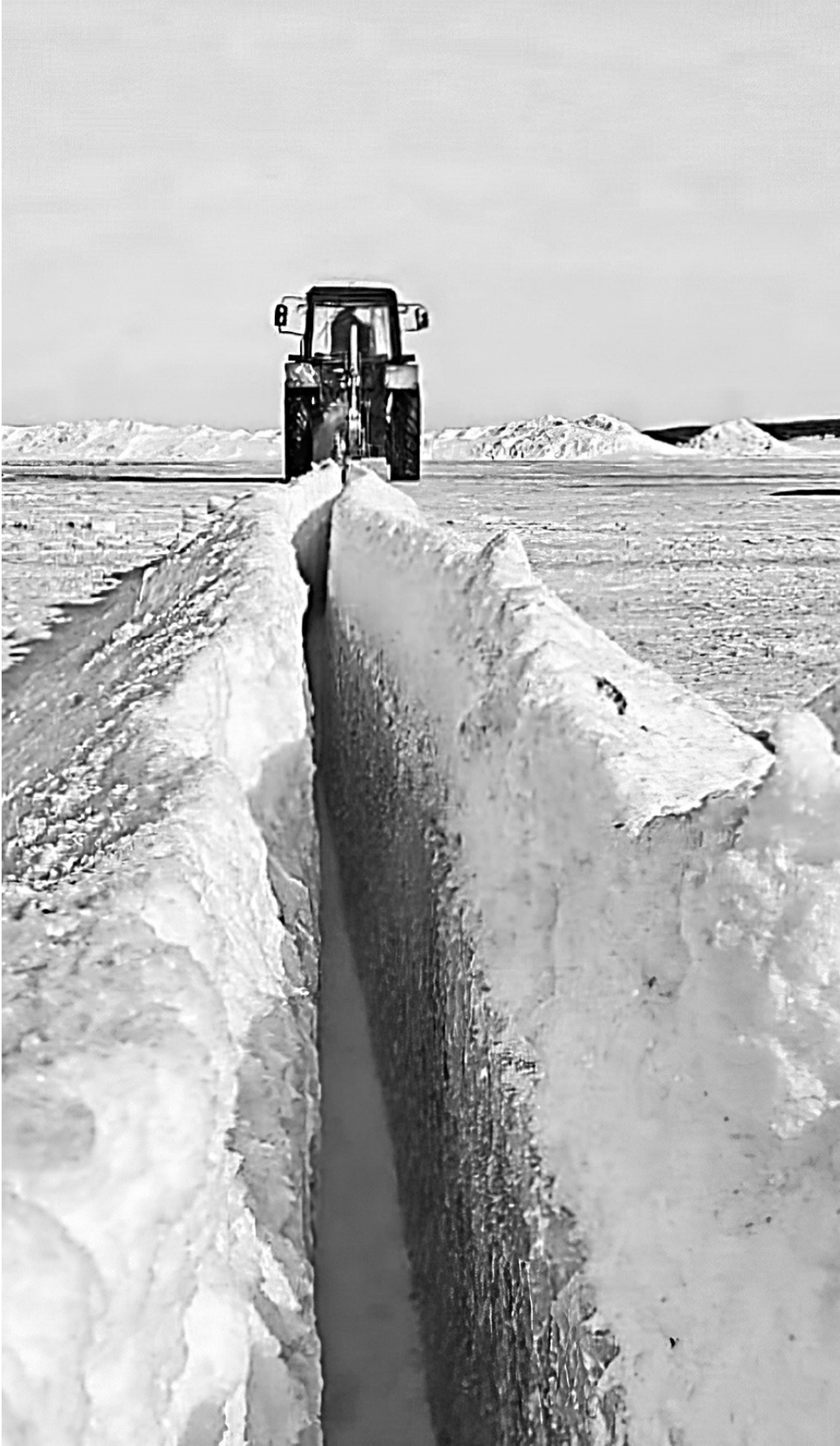
Распиловку льда на реках Якутии проводят для того, чтобы избежать заторов в период половодья.
