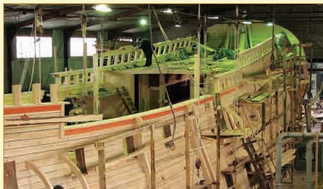
▼ Строительство полной ходовой копии первого линейного корабля русского флота «Гото Предестинация» в Петрозаводске ▲ 2013 г.
