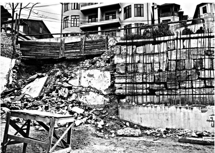
Вместо забетонированной пирамидальной стены появился пазл из старых бетонных блоков, который держится за счет арматуры.
