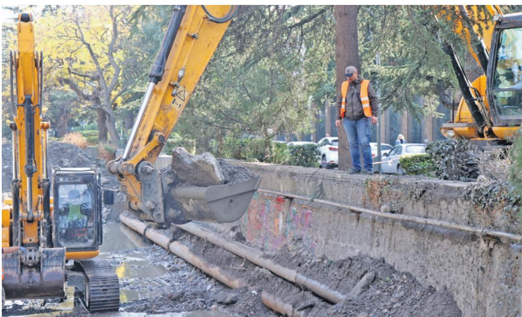
В Ялте до конца года планируют расчистить 1650 метров русел протекающих по центру города рек: Водопадной, Бабу и Дерекейки. На эти цели из резервного фонда РК выделено 30,5 миллиона рублей. В работах задействованы шесть экскаваторов и 15 самосвалов, ежедневно вывозят от 400 до 750 тонн грунта и щебня, которые минувшим летом стали одной из причин затопления центра курорта.
