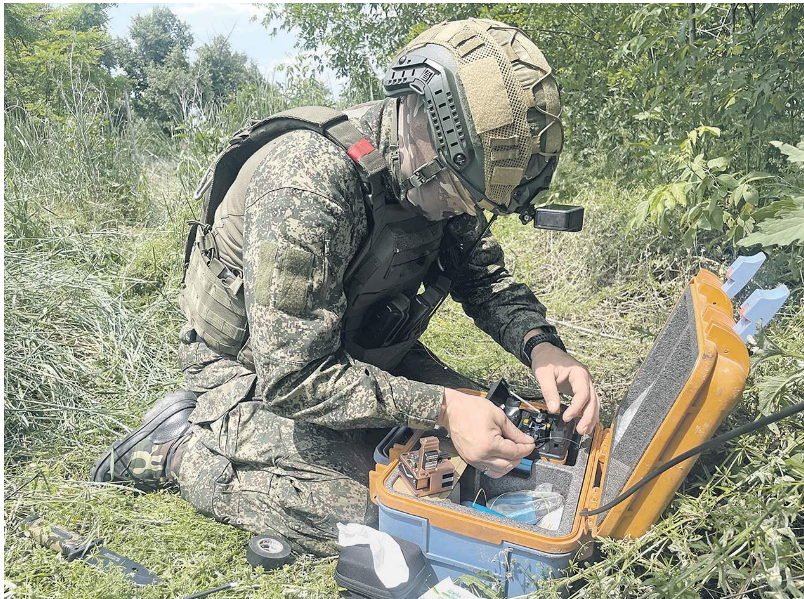
Устранение обрыва волоконно-оптической линии связи.
