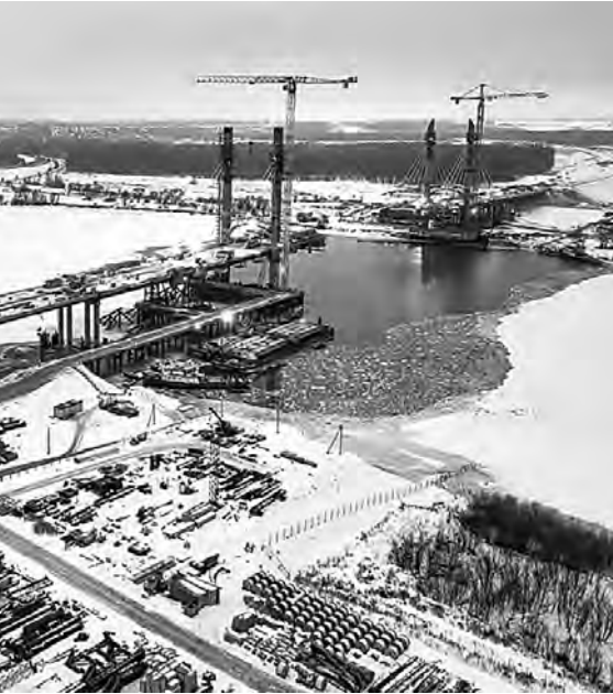
Установка вантовой системы позволит соединить части моста, уже возведенные с обоих берегов Оки.
