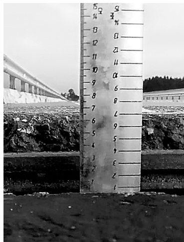
Смещение конструкций моста видно невооруженным глазом.
