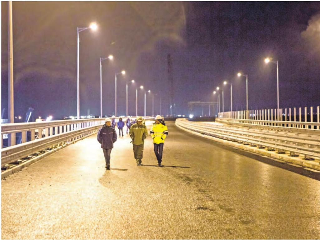
На четырех пролетах автодорожной части Крымского моста впервые протестировали систему наружного освещения. Контрольные замеры показали, что на разном расстоянии от проверенных 20 мачт уровень освещения выше расчетного — проектные требования соблюдены. После запуска моста в эксплуатацию система начнет работать автоматически: с приближением сумерек свет будет включаться, а утром отключаться. Всего дорожникам предстоит установить и протестировать более 1000 мачт освещения.
