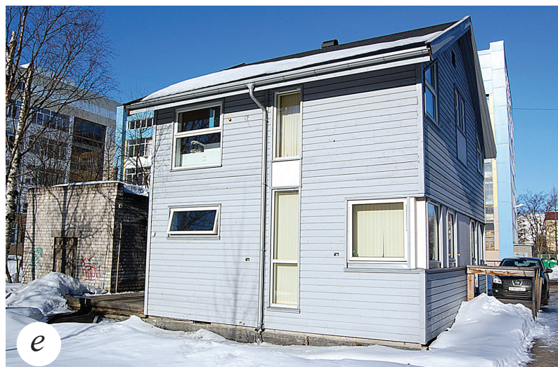
Рис. 1. Примеры малоэтажных домов: а – каменный дом; б – дом из оцилиндрованных брёвен; в – панельный дом; г – брусчатый дом; д – каркасный дом; е – дом из объёмно-блочных элементов
