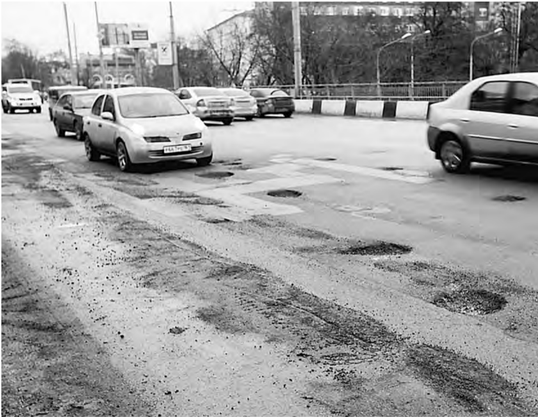
Дорожное покрытие моста на проспекте Стачки претерпело ямочный ремонт совсем недавно, все ростовчане помнят три дня столпотворения и абсолютной, 100-балльной пробки. Спустя всего месяц дорога выглядит так, будто ее бомбила авиация условного противника.
