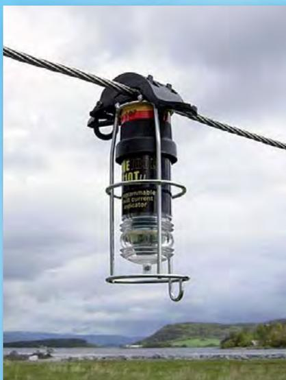
Класс напряжения 66-138 кВ. Пофазная индикация межфазных замыканий и замыканий на землю. Любая конфигурация ВЛ. Возможность передачи информации о повреждении диспетчеру по GSM или радиоканалу. Полная автономность.
